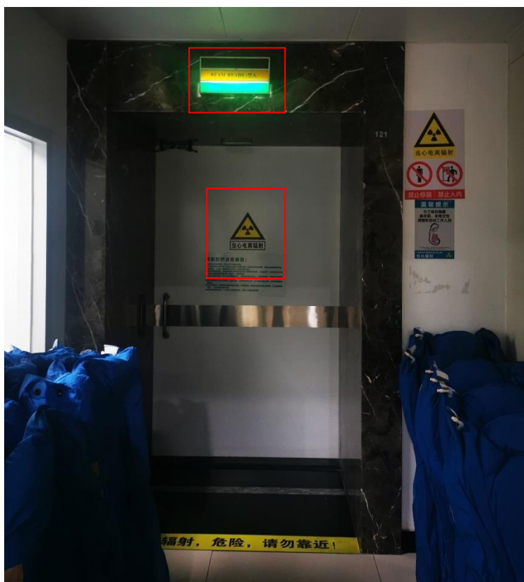
图 3-3 本项目加速器机房电离辐射警告标志及工作状态指示灯
