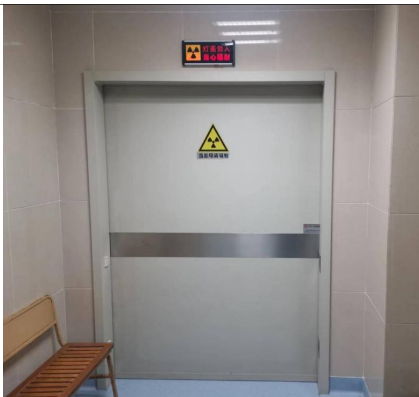
图3-2 本项目DSA机房工作状态指示灯和电离辐射警告标志
