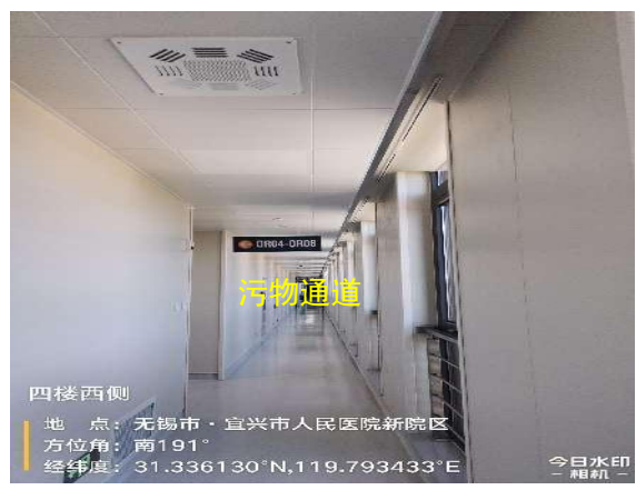
图 8-12 综合楼四楼手术室 4 西侧
