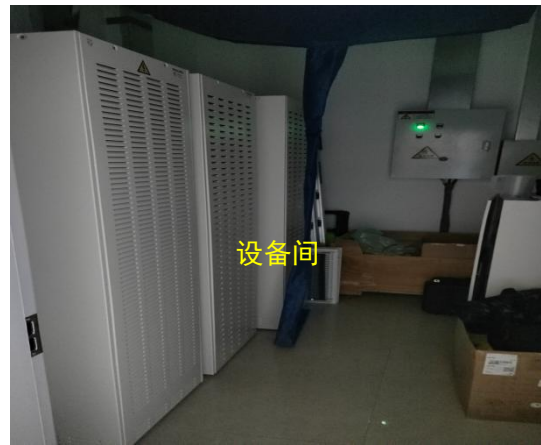
图 8-6 综合楼一楼急诊 DSA 室北侧
