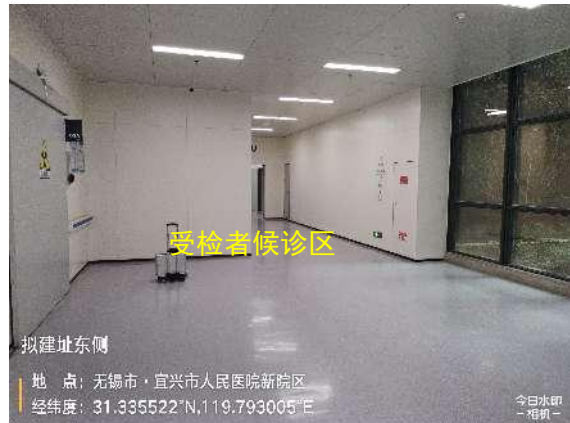
图 8-2 综合楼一楼急诊 DSA 室东侧
