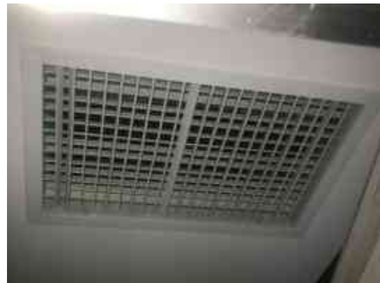
图3-6 2号直线加速器机房内通风装置
