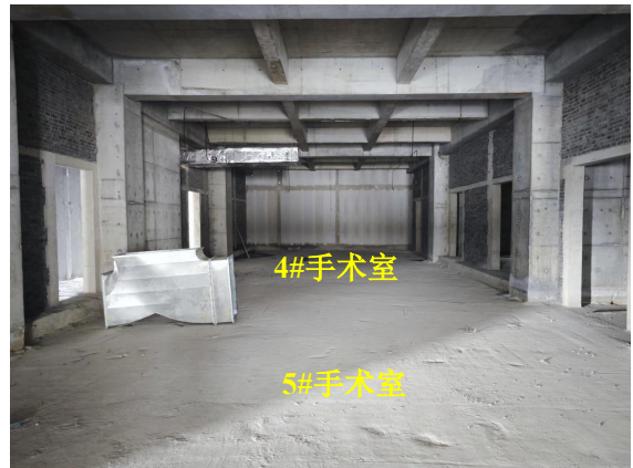
图 8-10 病房楼三楼 DSA 机房拟建址 (4#、5#手术室)
