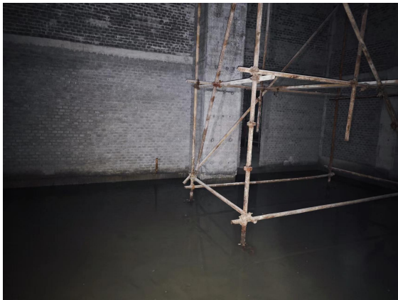
图 8-23 核医学科诊断区 SPECT/CT 室拟建址
