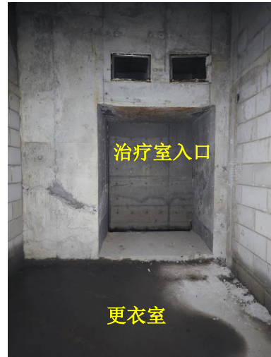
图 8-30 2#加速器机房北侧更衣室 (机房入口处)
