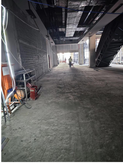
图 8-7 门诊医技楼 DSA 机房拟建址北侧过道
