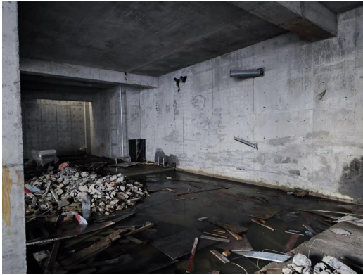
图 8-31 1#加速器机房东侧控制室、设备机房 拟建址
