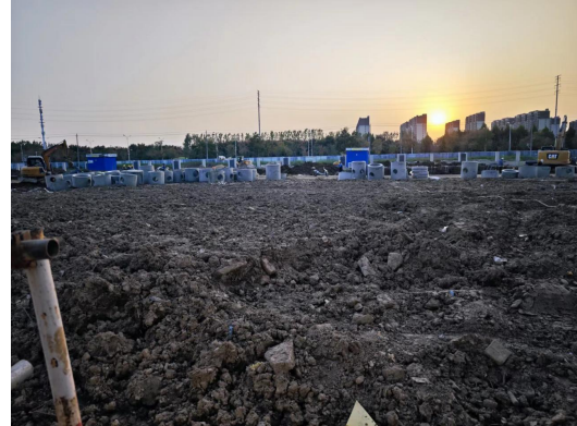
图 8-32 加速器机房西侧、南侧土层 拟建址
