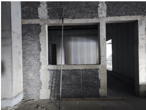
图 8-11 5#手术室拟建址东侧 (拟建控制室)
