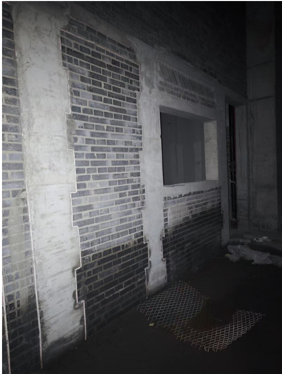
图 8-6 门诊医技楼 DSA 机房拟建址西侧 (拟建控制室)
