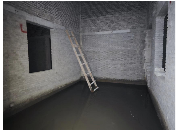
图 8-24 核医学科诊断区 PET/CT、SPECT/CT 控制室拟建址
