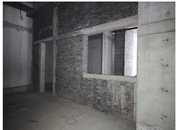
图 8-12 4#手术室拟建址东侧 (拟建控制室)
