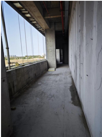
图 8-15 4#手术室拟建址北侧过道
