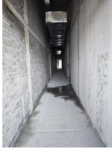
图 8-14 4#、5#手术室拟建址西侧过道
