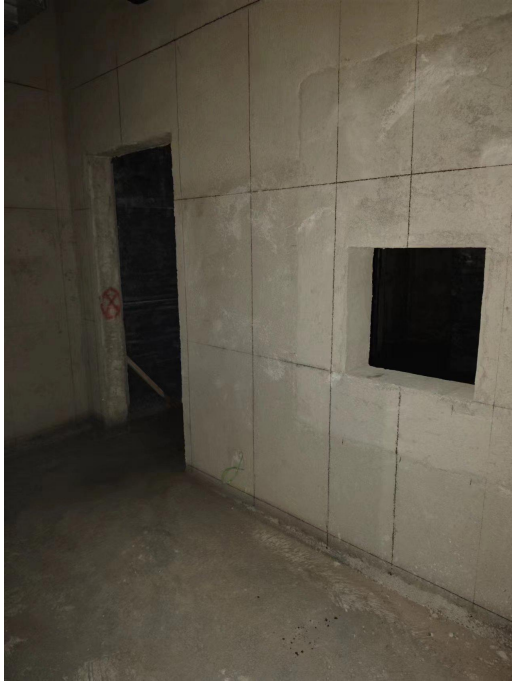
图 8-25 核医学科治疗区服碘室拟建址
