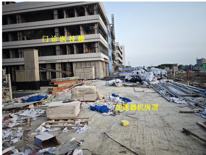
图 8-33 加速器机房顶上无建筑
