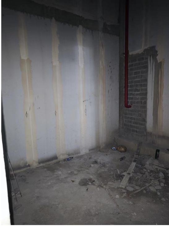
图 8-3 门诊医技楼 DSA 机房拟建址东侧 (拟建洗污打包间)
