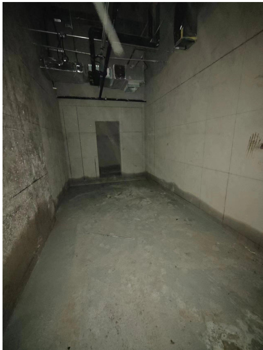
图 8-27 核医学科治疗区治疗室
