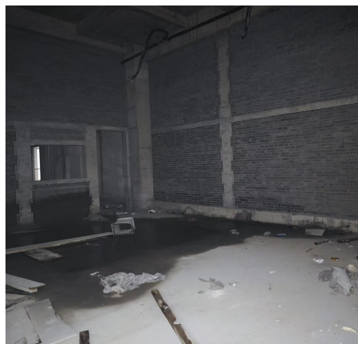
图 8-2 门诊医技楼一楼 DSA 机房拟建址
