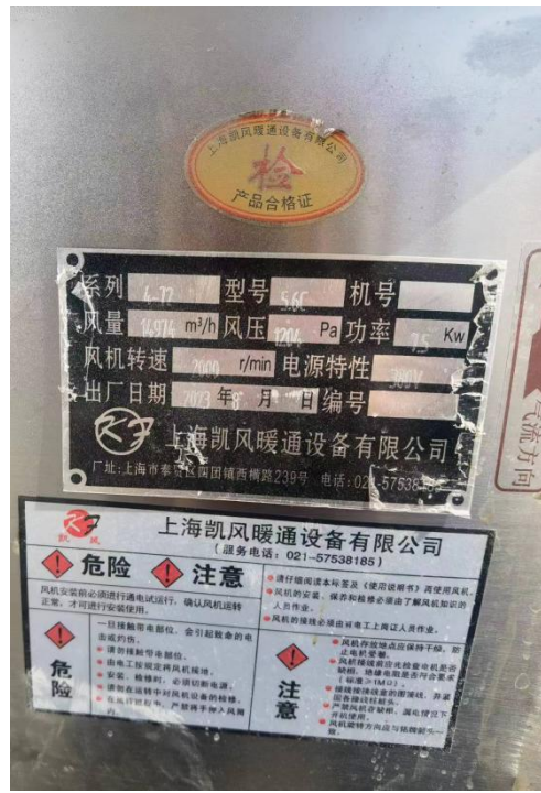
2#加速器配套风机铭牌
