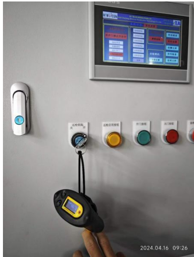
1#加速器安全联锁箱上钥匙开关
