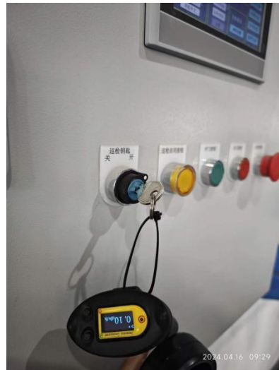
2#加速器安全联锁箱上钥匙开关
