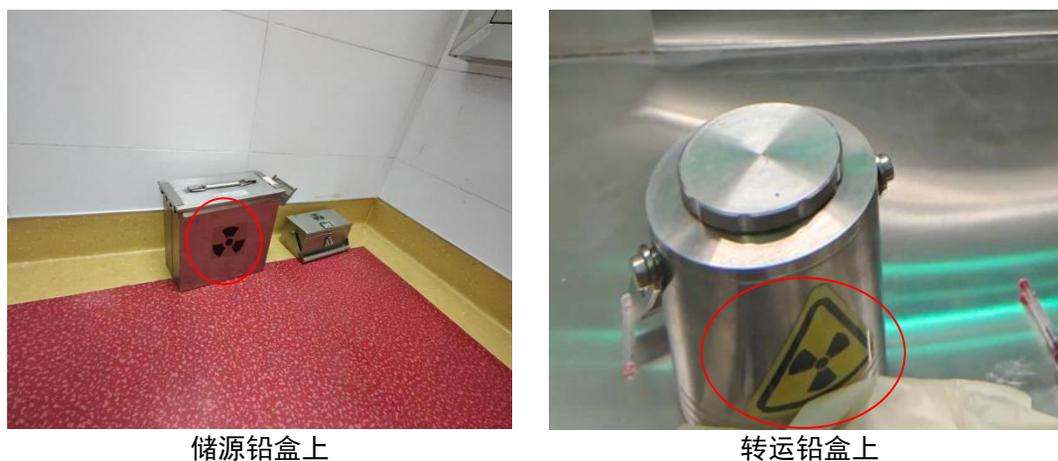
图3-3 电离辐射警告标志及电离辐射标志
