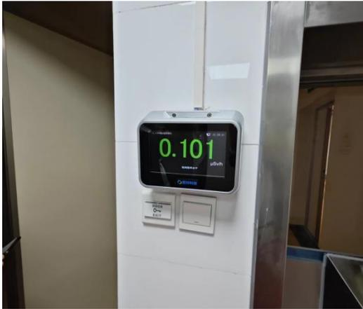
区域辐射测量仪（分装注射室内探头）
