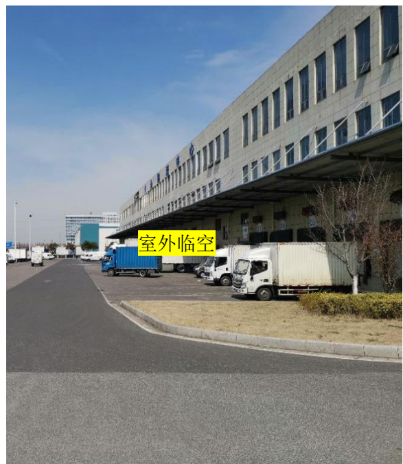
图 8-4 本项目放射性药物暂存拟建址西侧
