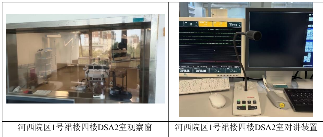
图3-3 本项目DSA机房观察窗及对讲装置
