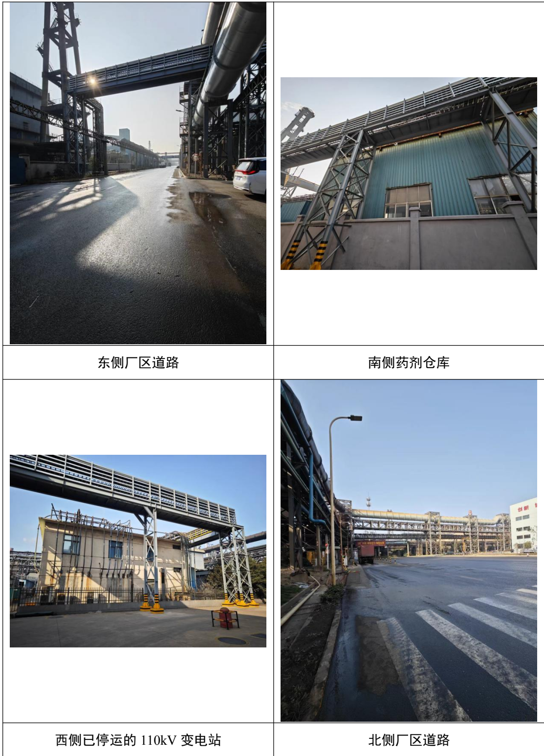
图 4-3 联峰 110kV9#变电站周围环境
