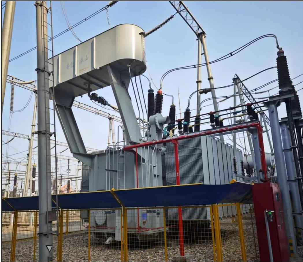
图 1-1 永联 3#主变压器外观
