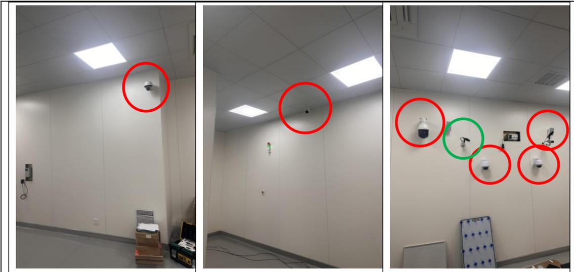
图3-12. 医用加速器机房监控（红圈）及对讲装置（绿圈）现场照片
