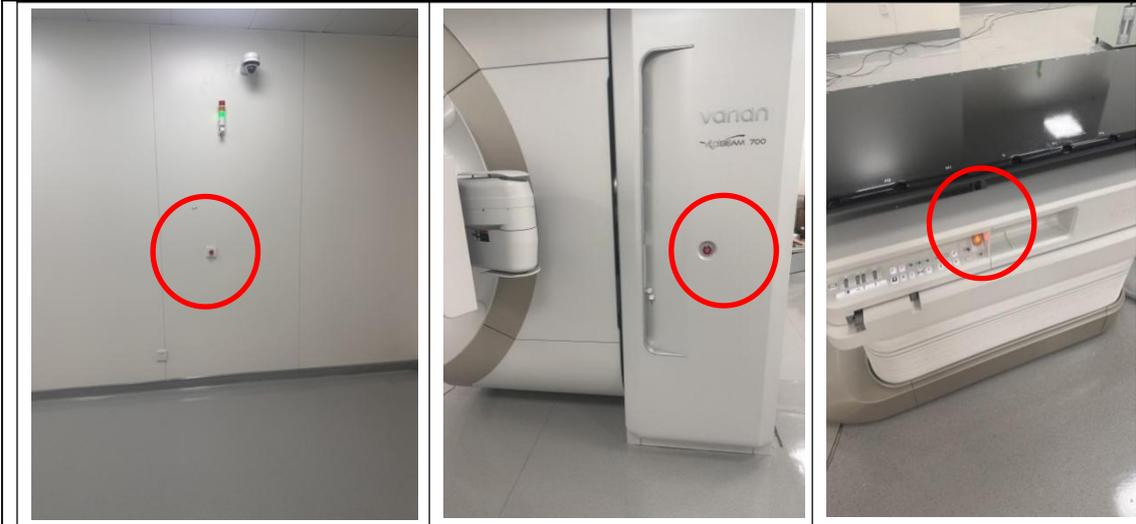
图3-8. 医用直线加速器机房急停开关现场照片
