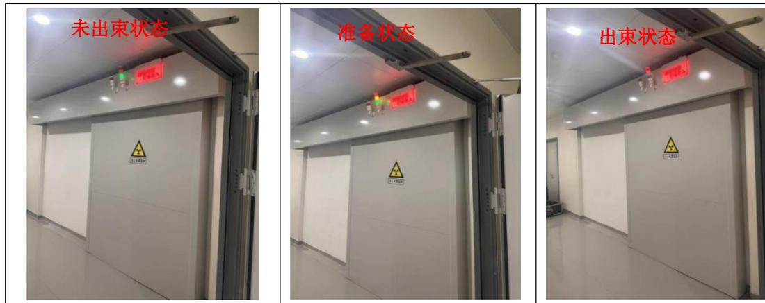
图3-6. 医用直线加速器机房工作状态指示灯和电离辐射警告标志
