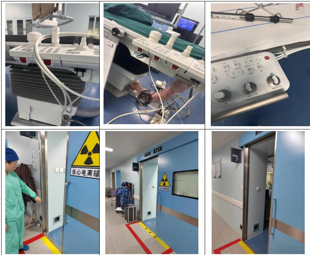
图3-9. DSA设备急停开关及脚感应式开门开关现场照片
