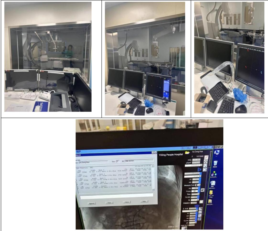
图3-10.观察、对讲装置、剂量显示现场照片
