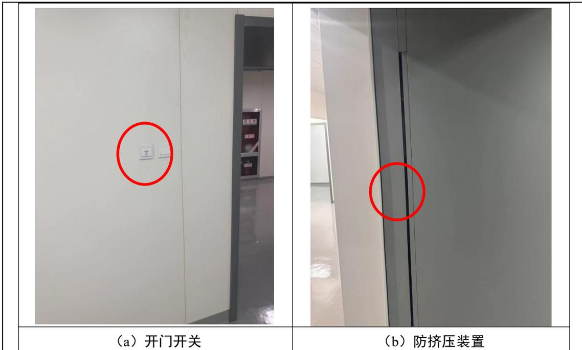
图3-13. 医用直线加速器机房开门开关和防挤压装置现场照片
