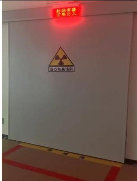
图3-21 PET/CT机房门灯联锁装置
