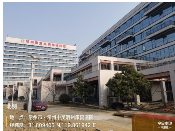
图 8-5 本项目伽玛刀机房拟建址北侧
