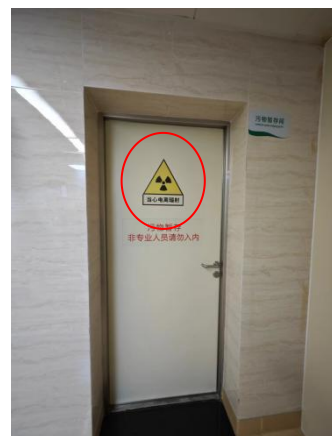
污物暂存间门上
