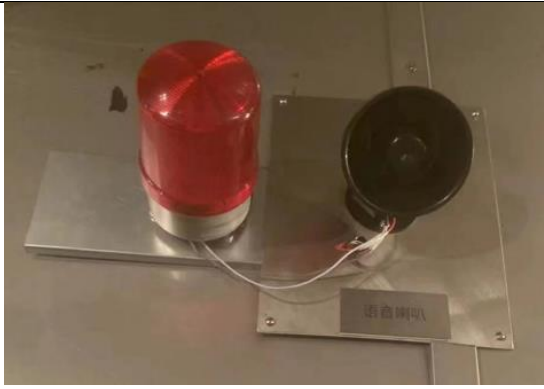
图3-13 2#加速器机房辐照室内音响警示信号 图3-14 3#加速器机房辐照室内音响警示信号
