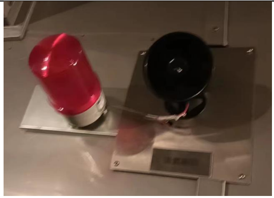
图3-13 2#加速器机房辐照室内音响警示信号 图3-14 3#加速器机房辐照室内音响警示信号
