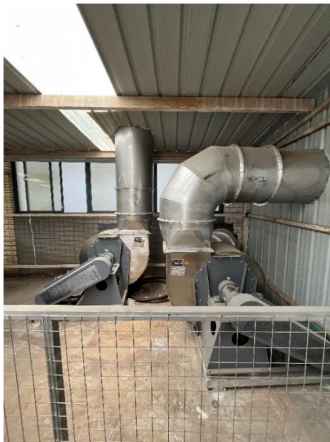
图3-30 机房外部风机及排风管道
