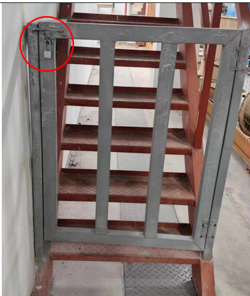
图3-4 通往二层设备平台的楼梯设带锁门
