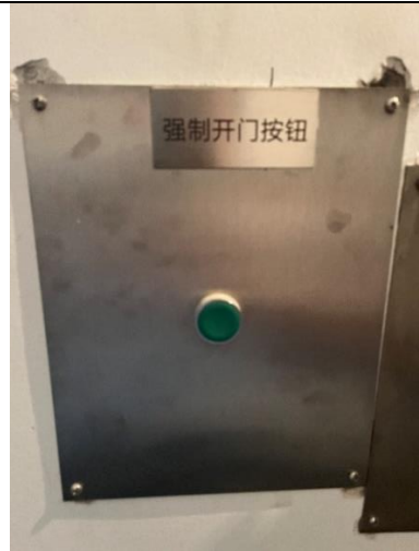
图3-23 2#加速器机房辐照室内紧急开门按钮 图3-24 3#加速器机房辐照室内紧急开门按钮
