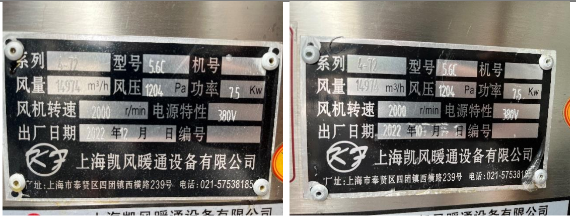
图3-27 2#加速器机房、3#加速器机房风机铭牌
