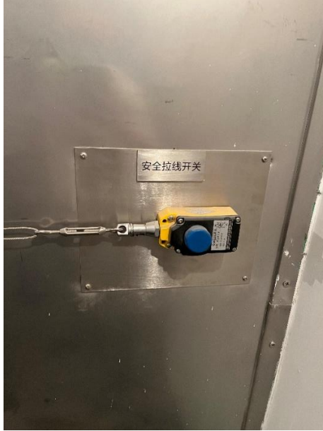
图3-21 2#加速器机房辐照室内拉线开关
