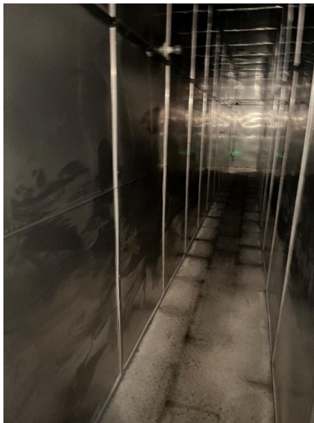
图3-22 3#加速器机房辐照室内拉线开关
