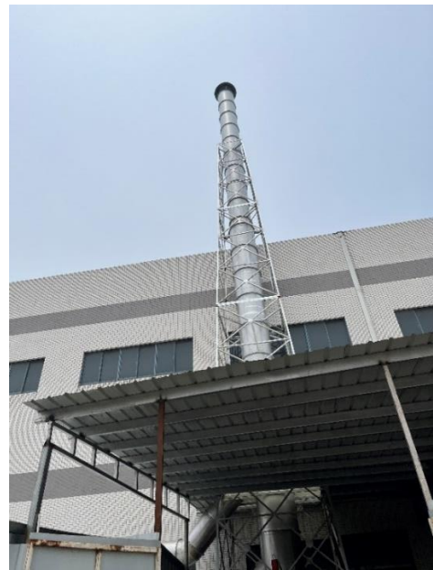
图3-30 机房外部风机及排风管道
