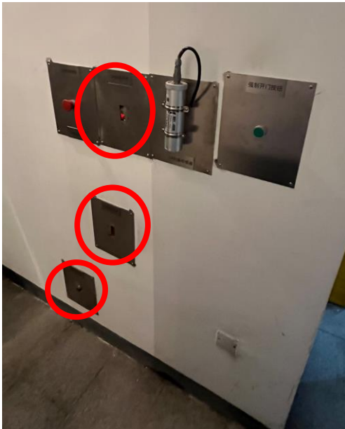
图3-19 2#加速器机房光电装置高度分布
