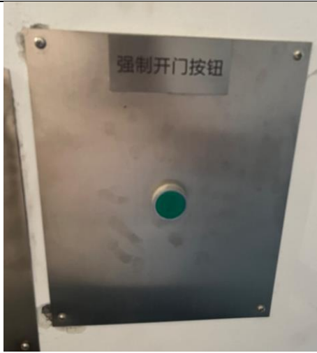
图3-23 2#加速器机房辐照室内紧急开门按钮 图3-24 3#加速器机房辐照室内紧急开门按钮
