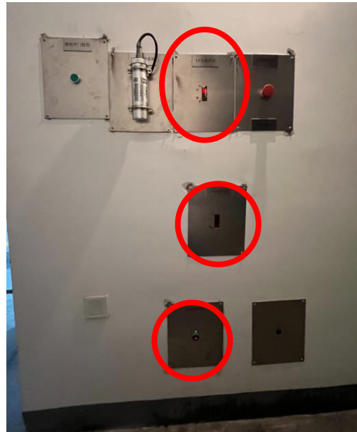
图3-20 3#加速器机房光电装置高度分布
