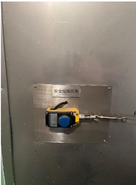
图3-22 3#加速器机房辐照室内拉线开关
