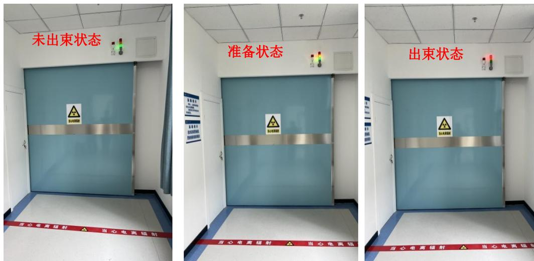
图3-2 医用直线加速器机房工作状态指示灯和电离辐射标志现场照片
