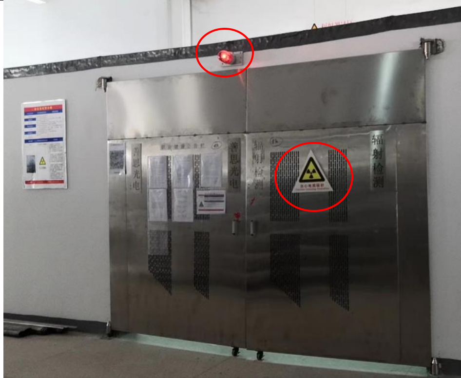
图3-3 辐射调试区入口处工作状态指示灯和电离辐射警告标志
