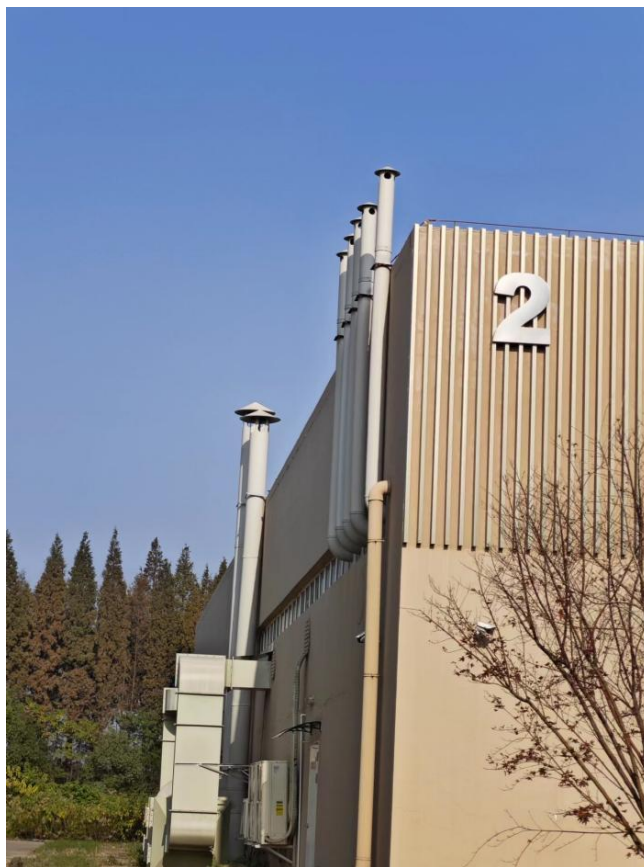
2号厂房西侧楼顶排气口
