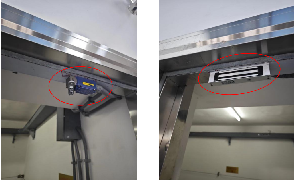
图3-9 门机联锁机构
