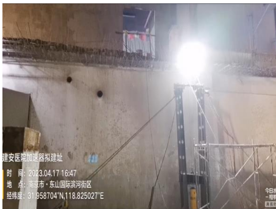
图 8-5 本项目医用直线加速器机房拟建址西北侧
