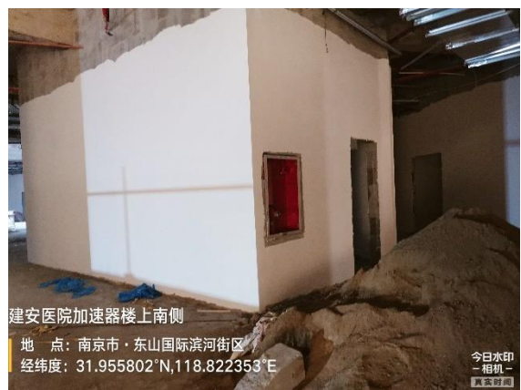
图 8-6 本项目医用直线加速器机房拟建址楼上
