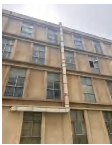
(h) 东北侧室外管道
