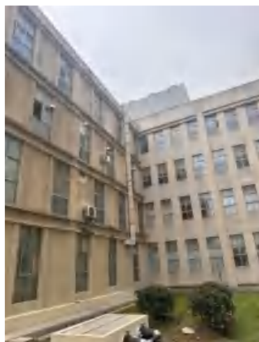
(g) 西北侧室外管道
