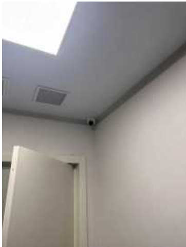
(d) 注射后候诊室监控装置
