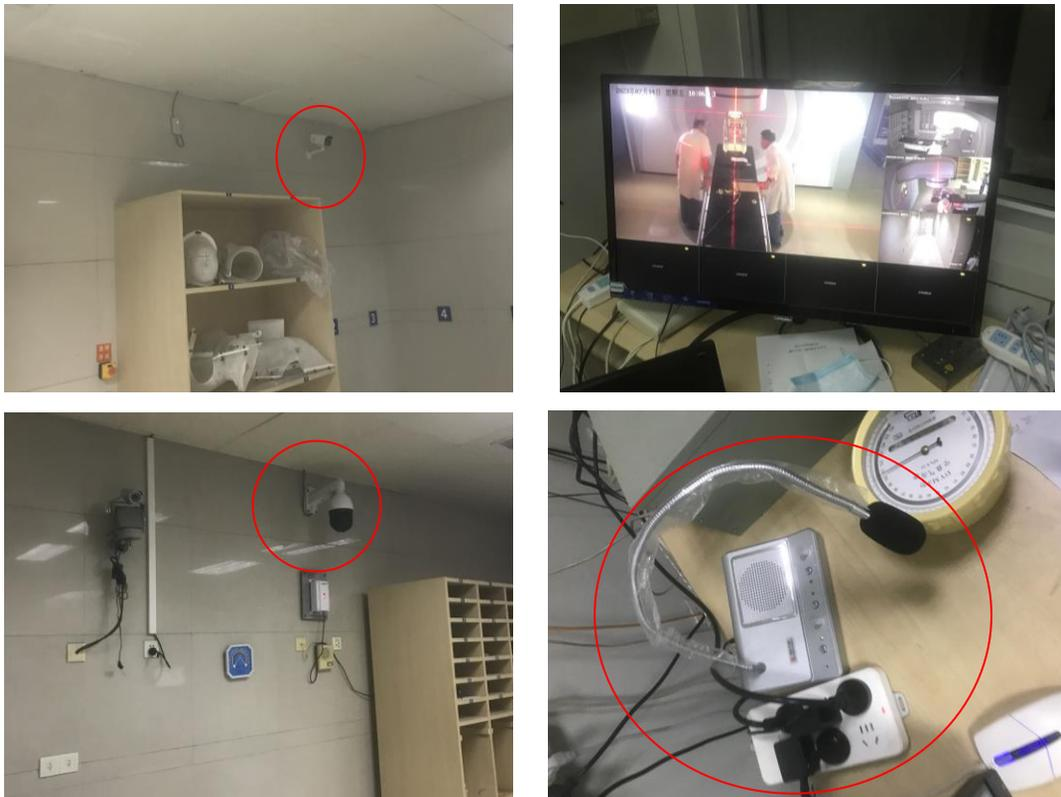
图3-3 加速器机房视频监控和对讲系统
