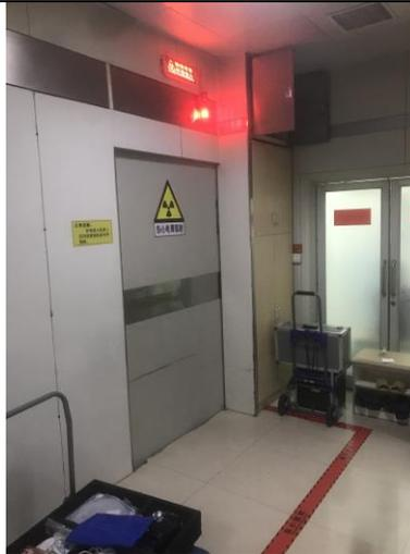
图3-2 工作状态指示灯和电离辐射警告标志
