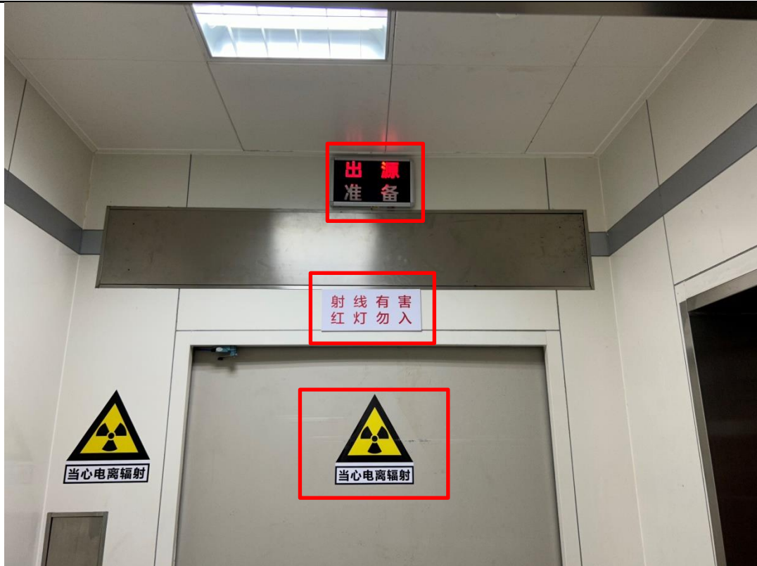
图3-5 工作状态指示灯与电离辐射标志
