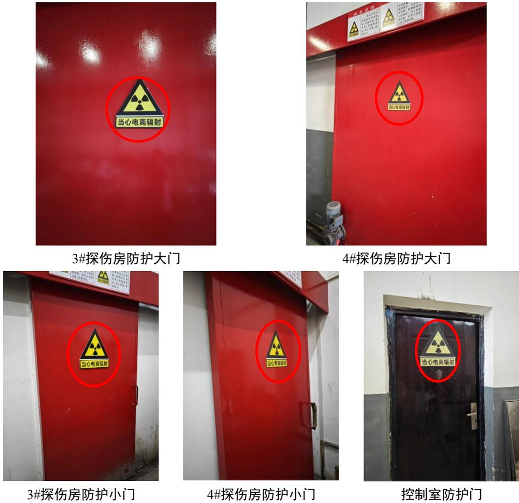
图3-3 本项目设置的电离辐射警告标志
