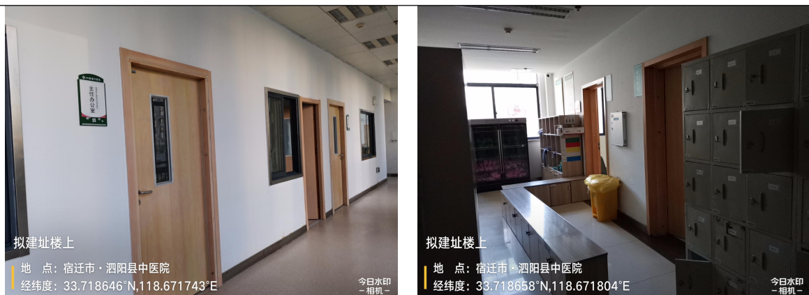
图 8-6 本项目 DSA 机房拟建址楼上（更衣室和办公室）
