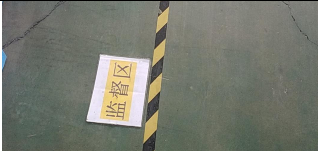
图3-3-2本项目加速器辐照室外监督区标识
