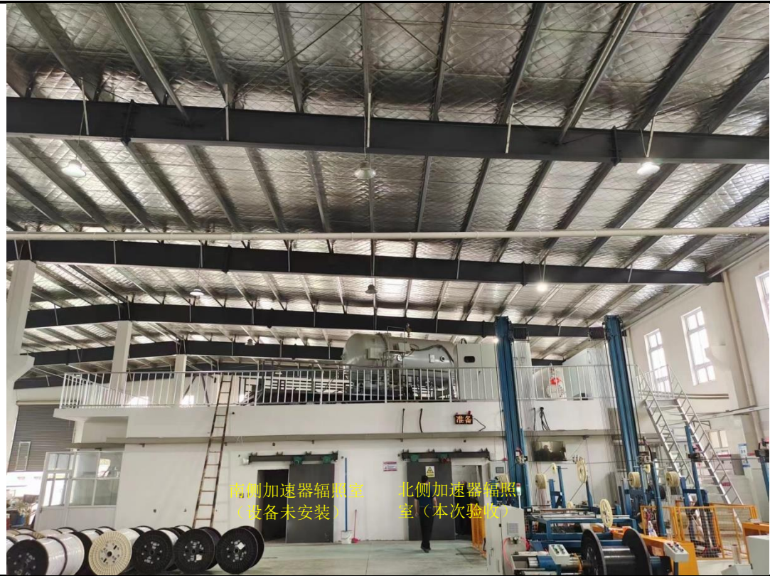
图3-2 本项目加速器辐照室现场正面图
