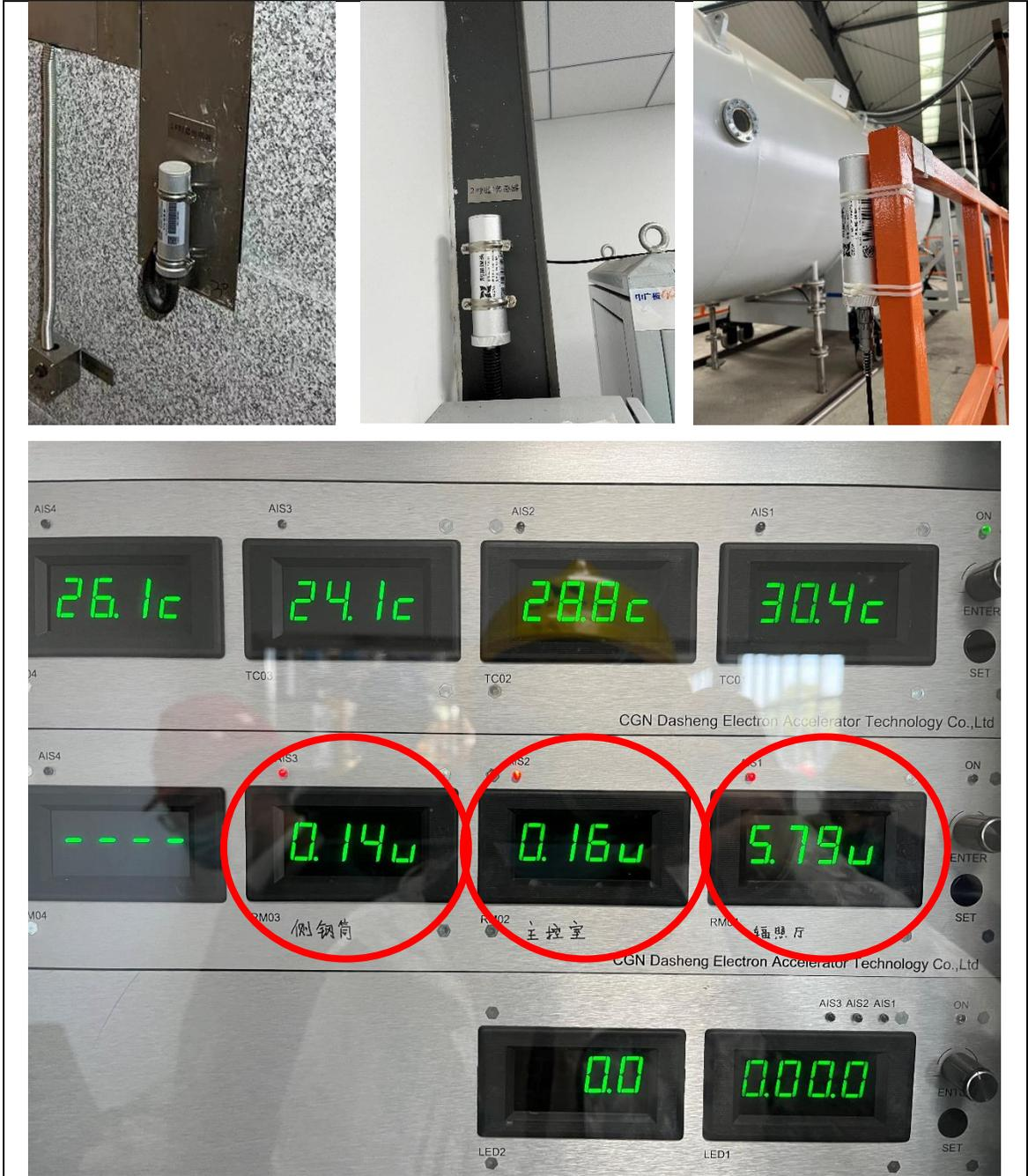
图3-13 4#加速器机房固定式辐射监测系统
