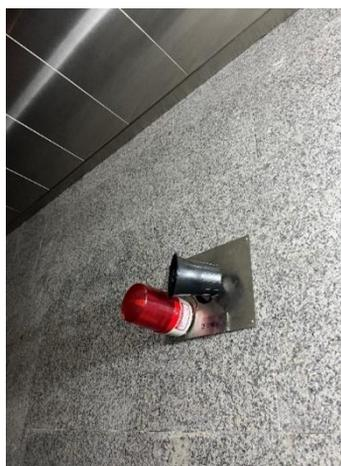
图3-8 4#加速器机房辐照室内部灯光和音响警示信号
