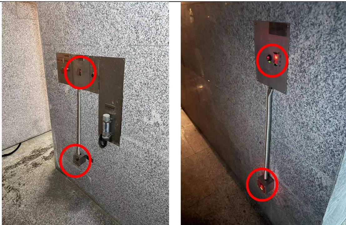
图3-10 4#加速器机房辐照室内防人误入装置
