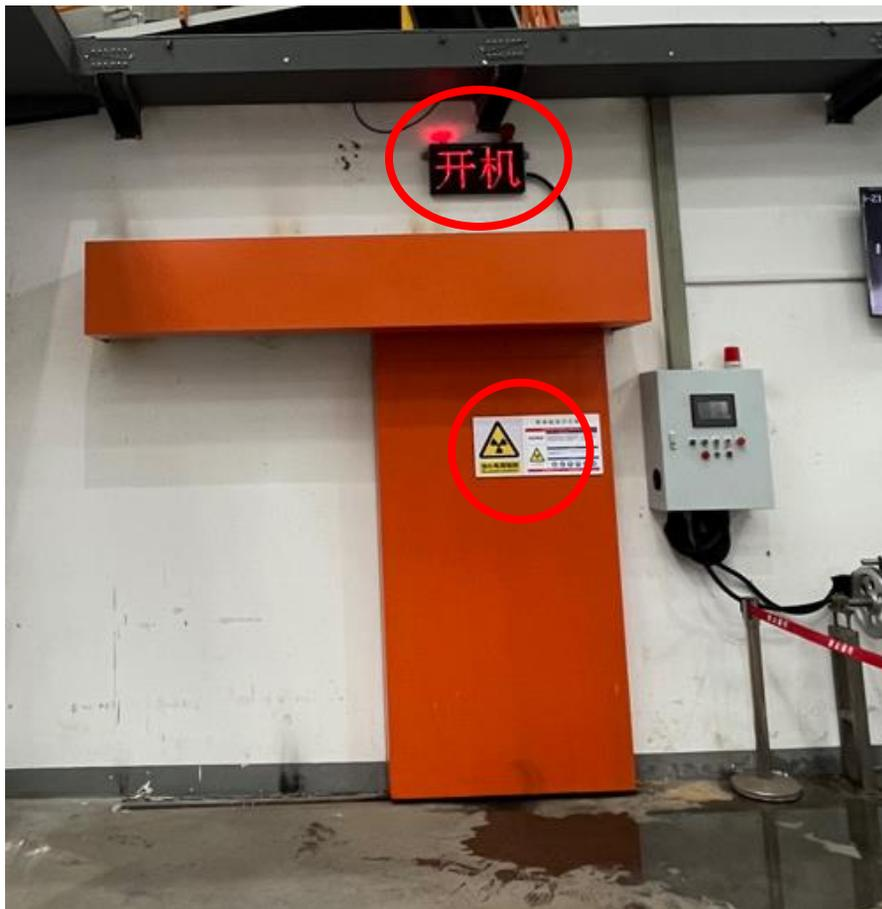
图3-7 4#加速器机房防护门处工作状态指示灯和电离辐射警告标志
