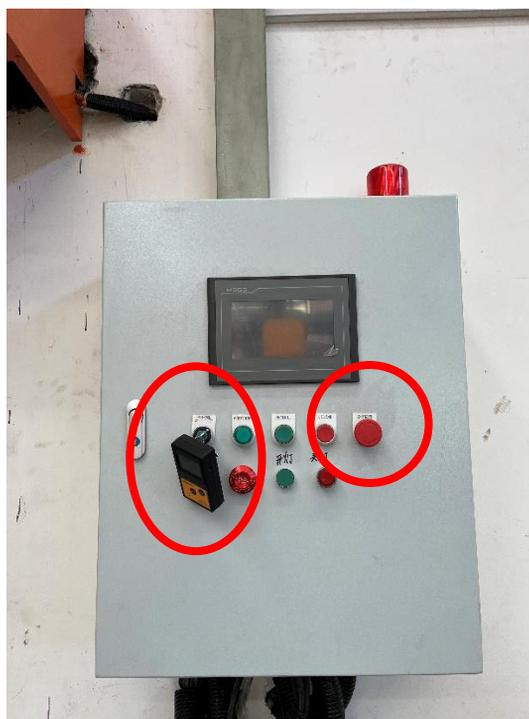
图3-6 4#加速器机房防护门钥匙开关和急停
