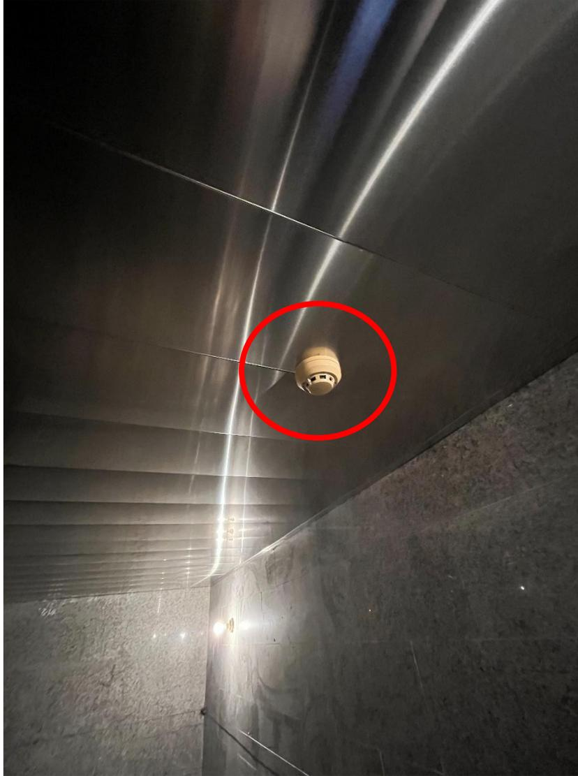
图3-16 4#加速器机房辐照室内烟雾报警器
