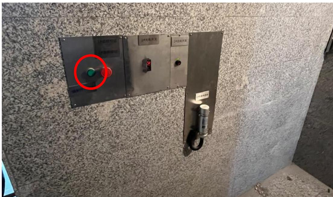
图3-12 4#加速器机房辐照室内部强制开门按钮
