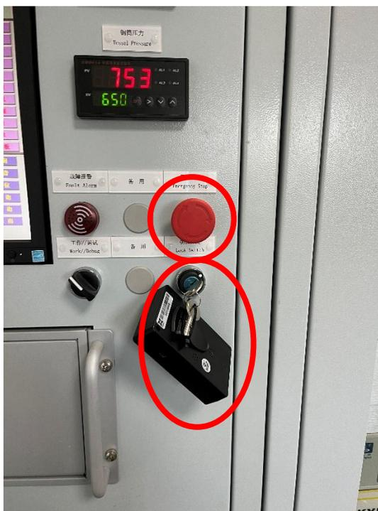
图3-5 4#加速器机房主控台钥匙开关和急停
