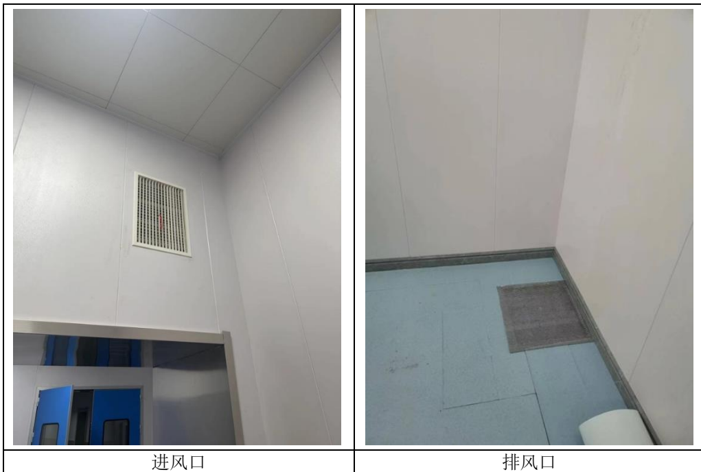
图 3-14 本项目陀螺刀机房进风口和排风口示现场验证照片
