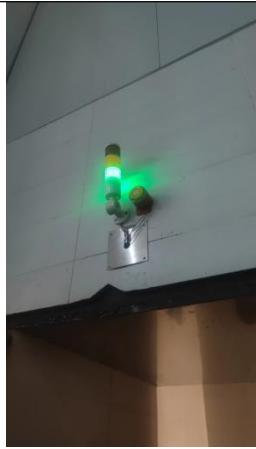
5#机房辐照室门口
