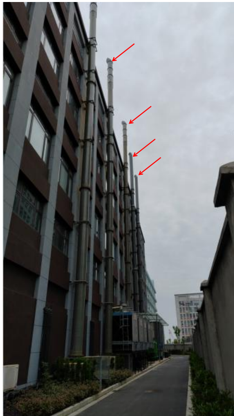
图3-18 加速器机房排风管道建设情况示意图
