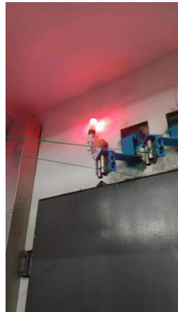
4#机房辐照室门口
