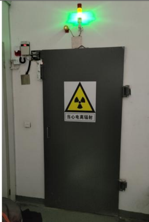
主机室防护门上
