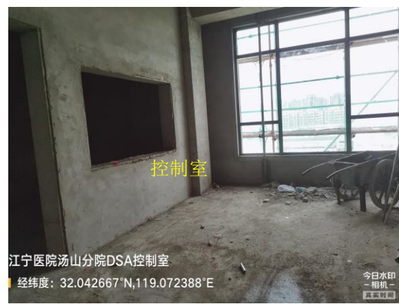
图 8-2 本项目 DSA 机房拟建址东侧
