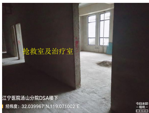
图 8-7 本项目 DSA 机房拟建址楼下
