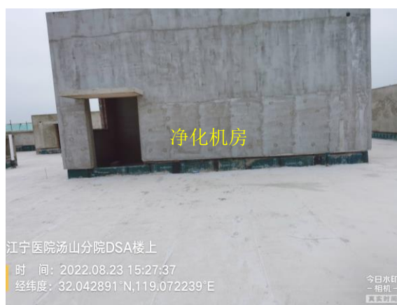
图 8-6 本项目 DSA 机房拟建址楼上
