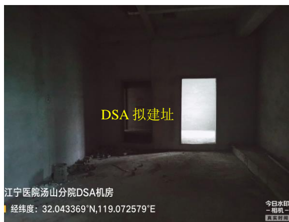
图 8-1 本项目 DSA 机房拟建址
