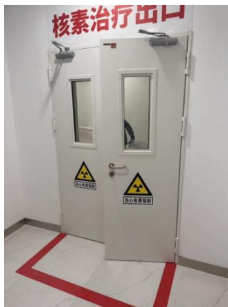
(h) 核素治疗区控制区出口
