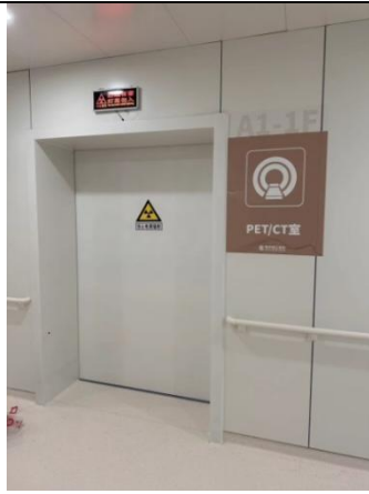
(d) PET/CT机房防护门
