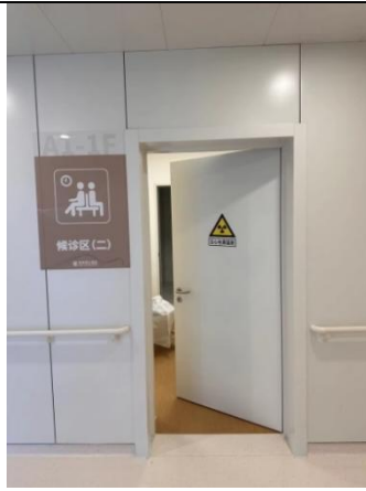
(e) 注射后候诊室防护门
