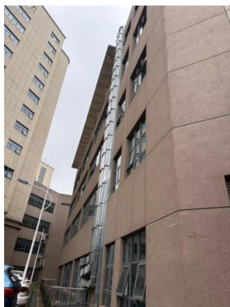
(h) 西北侧室外管道
