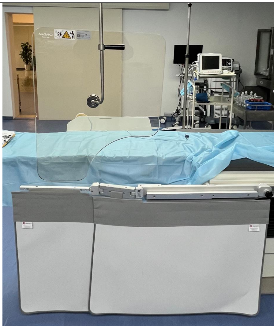
图3-7 DSA设备床侧防护设施
