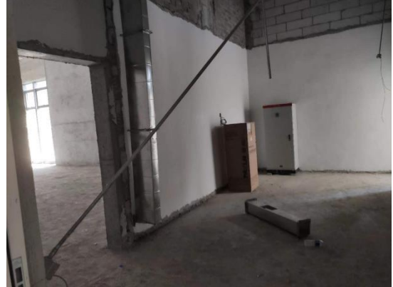
图 8-16 急诊楼杂交手术室（2）拟建址南侧 （缓冲间和污物通道）
