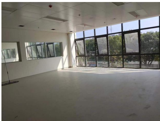
图 8-19 急诊楼杂交手术室（2）拟建址上方 （中毒中心病房）
