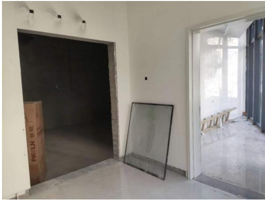
图 8-9 急诊楼杂交手术室（1）拟建址南侧 （诊室、过道和设备间）
