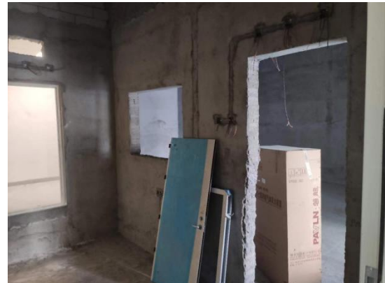
图 8-8 急诊楼杂交手术室 (1) 拟建址东侧 (控制室和设备间)
