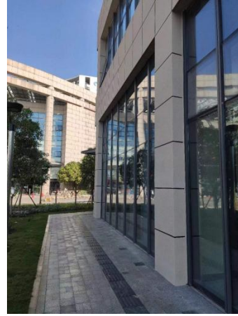
图 8-10 急诊楼杂交手术室（1）拟建址西侧 （室外）
