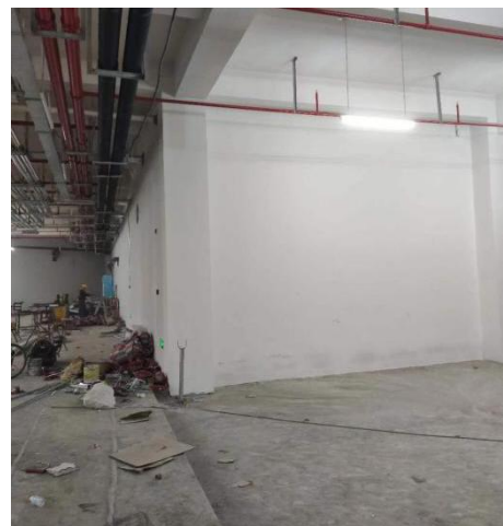
图 8-20 急诊楼杂交手术室（2）拟建址下方 （配电间）
