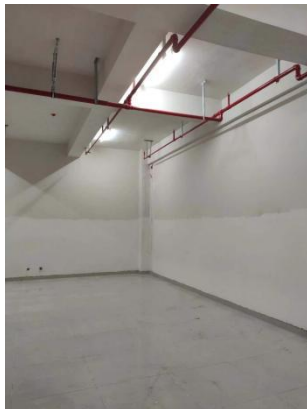
图 8-13 急诊楼杂交手术室（1）拟建址下方 （后勤库房）
