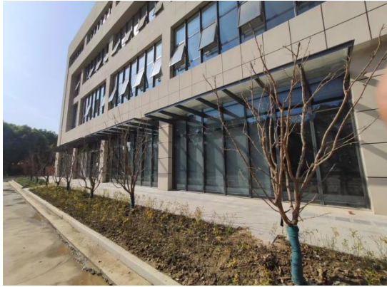
图 8-15 急诊楼杂交手术室（2）拟建址东侧 （室外）
