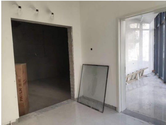
图 8-11 急诊楼杂交手术室（1）拟建址北侧 （处置室和过道）
