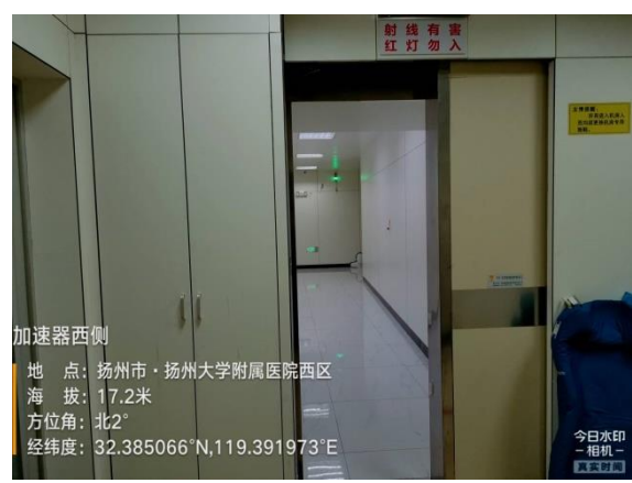
图 8-2 医用加速器机房西侧
