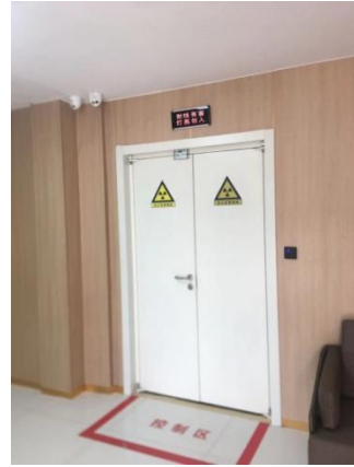
(c) 控制区入口防护门
