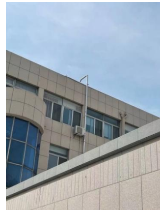
(e) 楼顶排风管道
