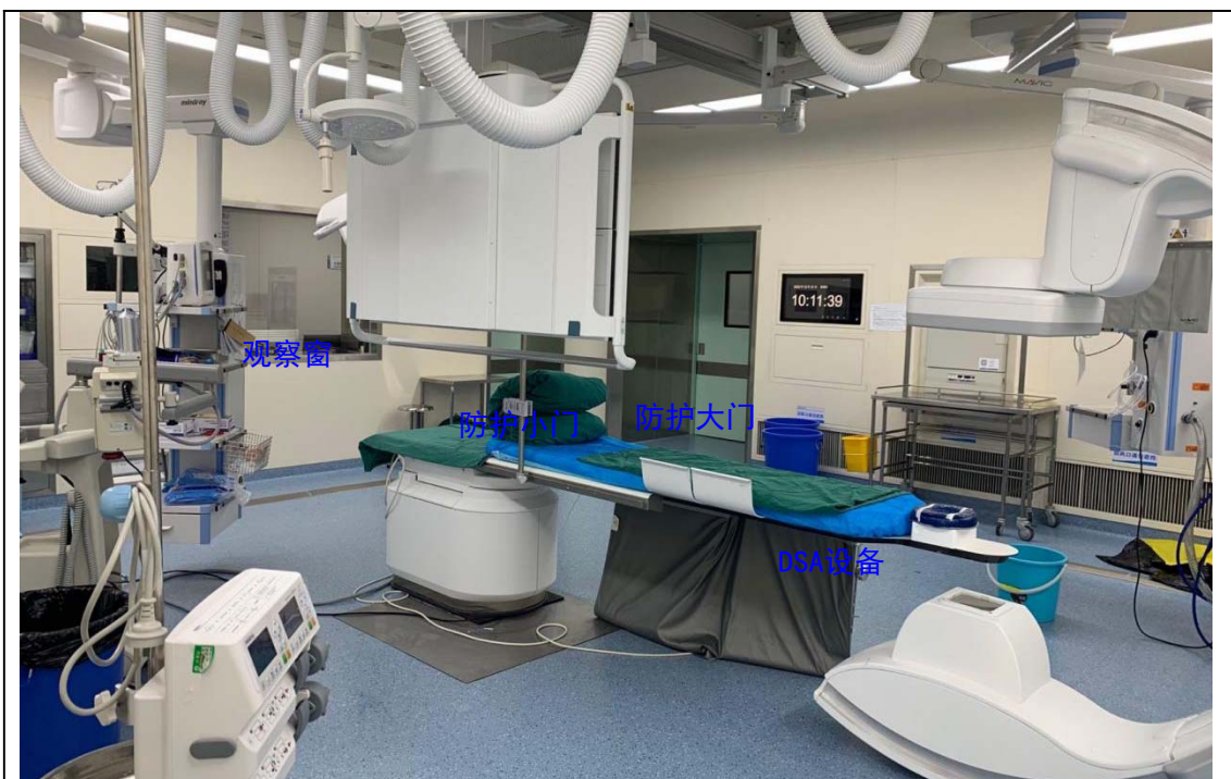
图3-2 如东县人民医院外科大楼四层DSA机房现场照片
