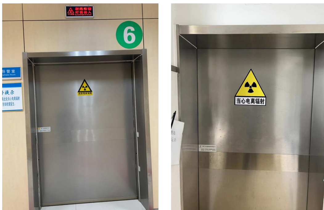
图3-3 工作状态指示灯和电离辐射警告标志
