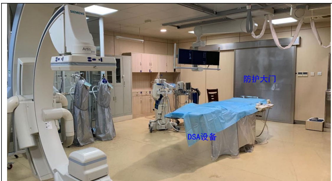
图3-2 如东县人民医院门急诊大楼一层DSA机房现场照片
