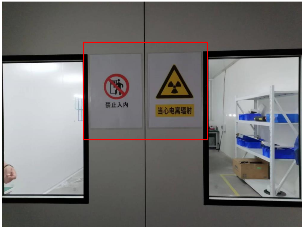
图3-3 CT检测室入口处电离辐射警告标志
