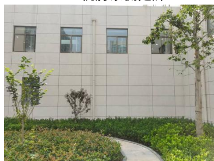
DSA机房西侧急诊医技楼外部地面
