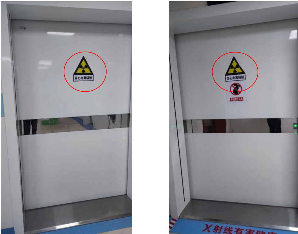
图3-3 DSA机房门上电离辐射警告标志
