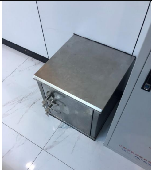
储源保险箱（PET/CT 机房）
