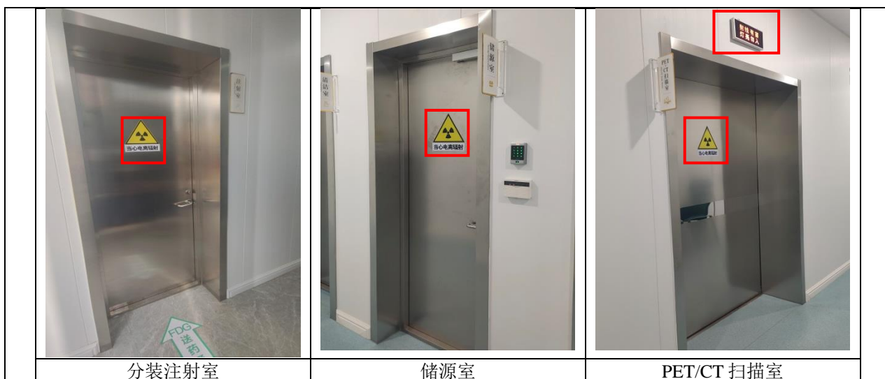
图3-2 本项目核医学工作场所工作状态指示灯和电离辐射警告标志
