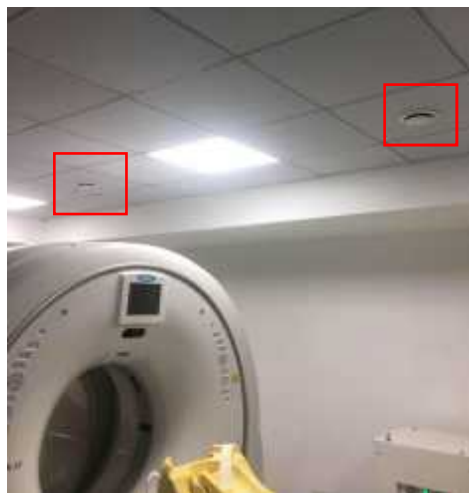
图 3-11 机房内通风装置
