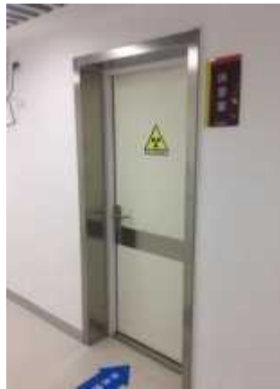
(d) 注射后候诊室防护门
