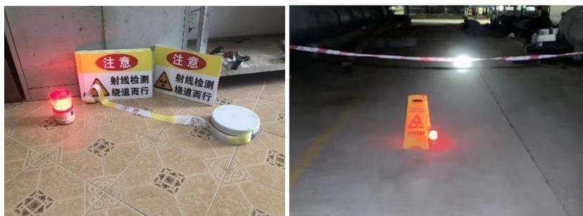
图3-2声光报警装置和警戒线
