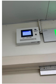
核医学工作场所固定式 X- \gamma 辐射监测报警仪
