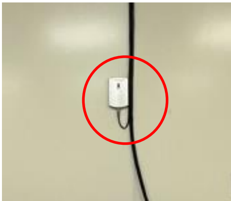
加速器机房固定式 X- \gamma 辐射监测报警仪
