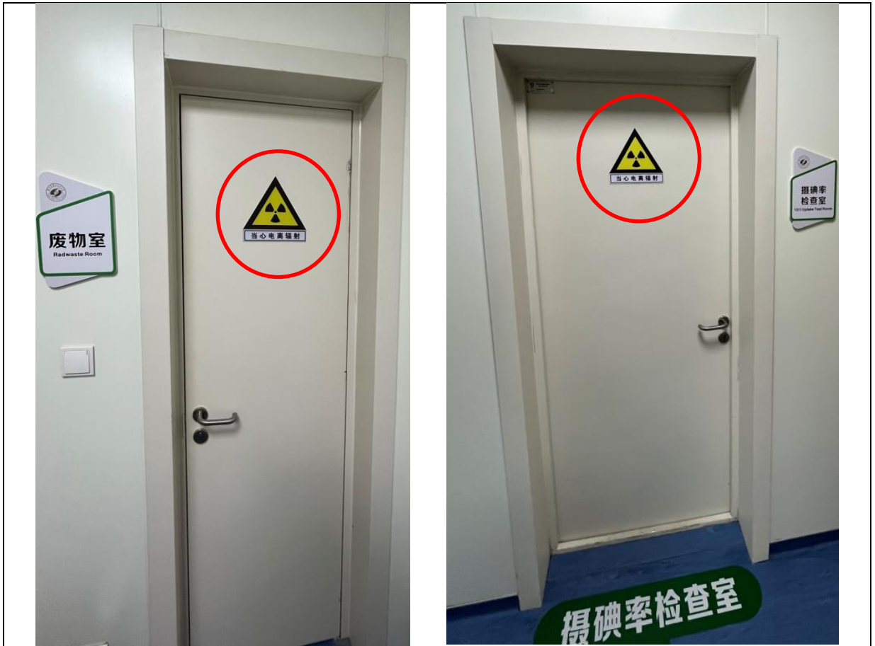
图3-9 核医学工作场所各功能房间门上电离辐射警告标志
