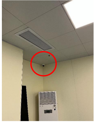
SPECT/CT室内东南角摄像头
