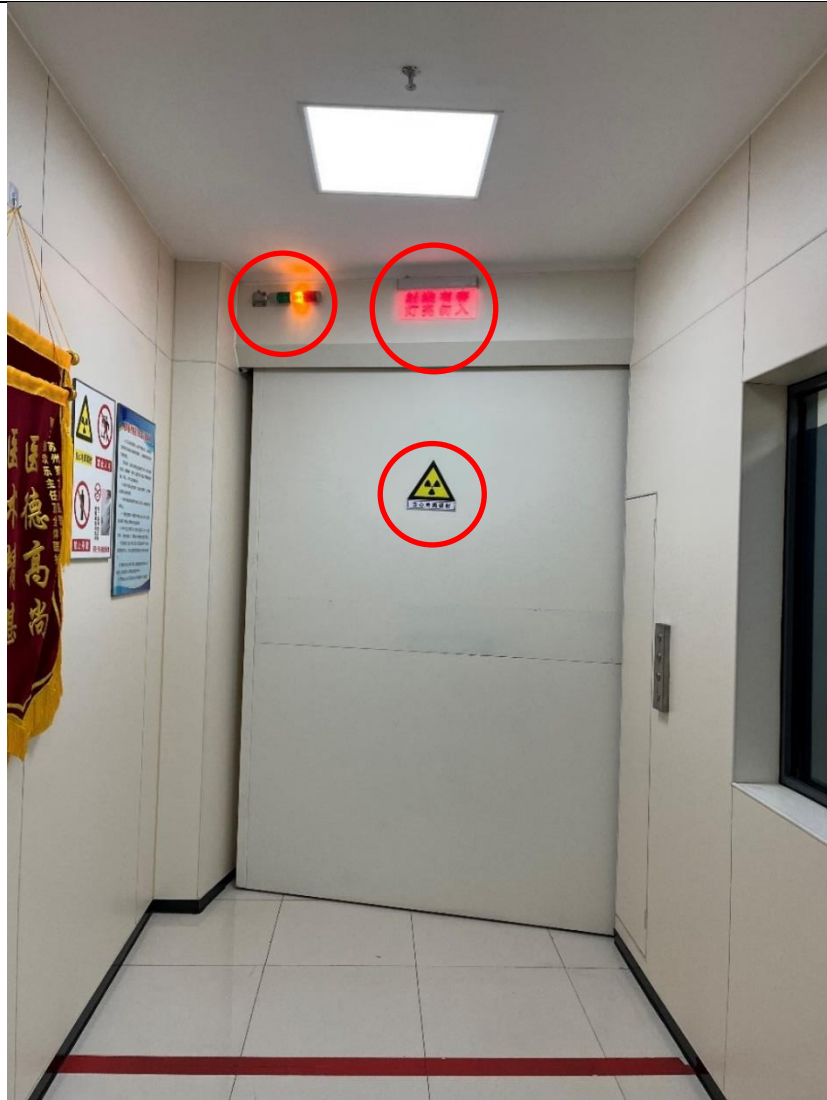
图3-4 1号加速器机房入口门上电离辐射警告标志和工作状态指示灯
