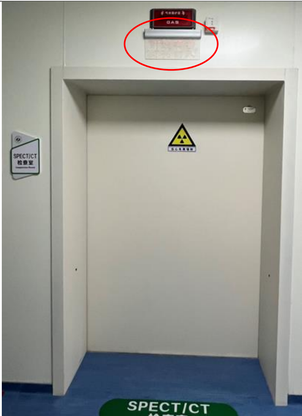
图3-12 SPECT/CT室工作状态指示灯
