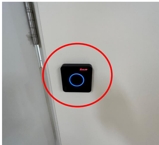
图3-16 外部门禁刷卡器
