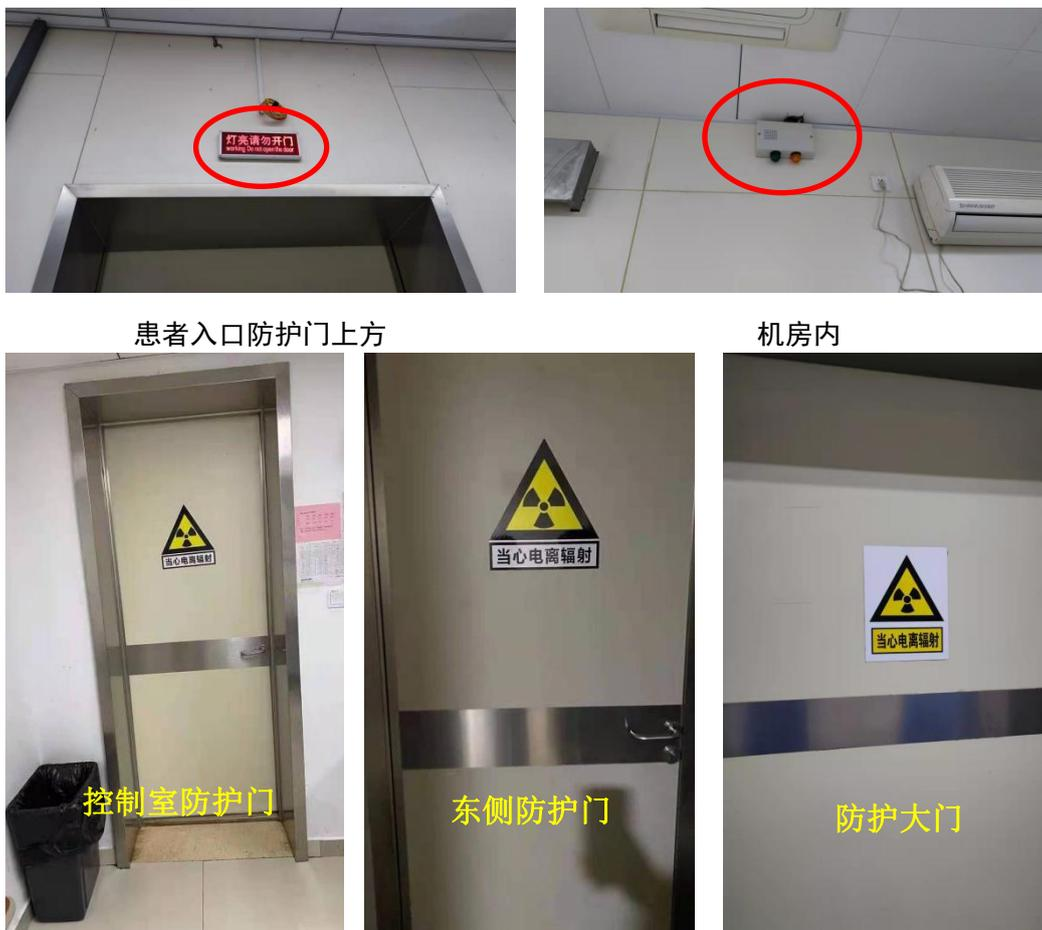
图 4-2 工作状态指示灯和电离辐射警告标志
