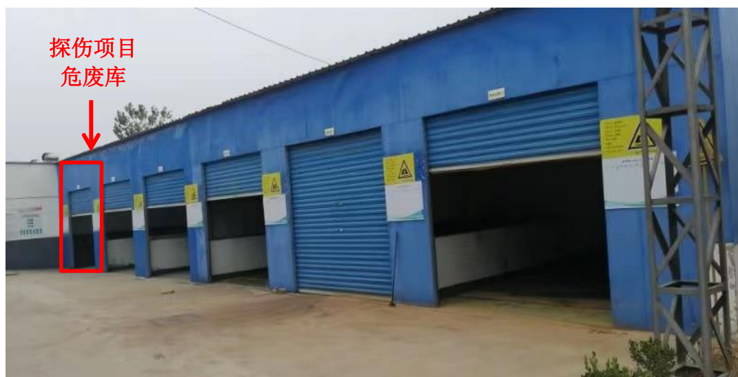
图3-6 新厂区危废库
