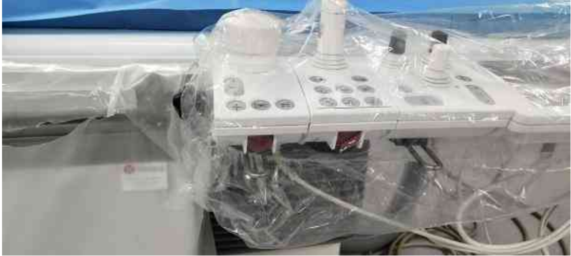
(a) DSA 机房内设备上
