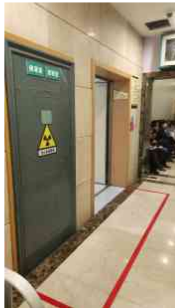
(e) 储源室/废物室防护门
