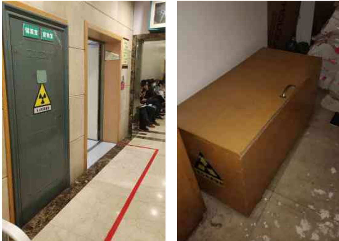
图 3-11 储源室/废物室及室内放射性废物箱
