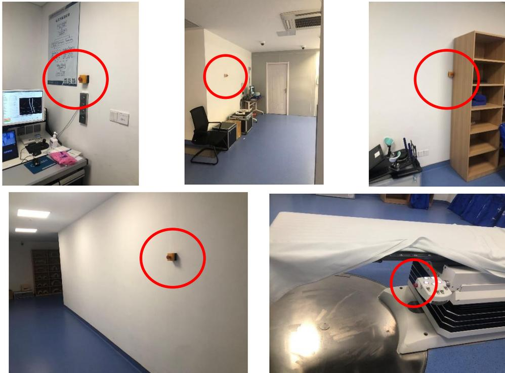
图3-10 加速器治疗室和控制室急停开关
