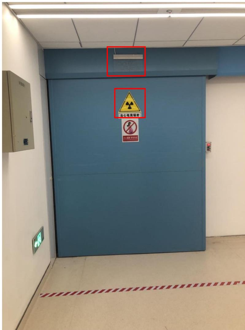
图 3-5 1号加速器机房电离辐射警告标志和工作状态指示灯
