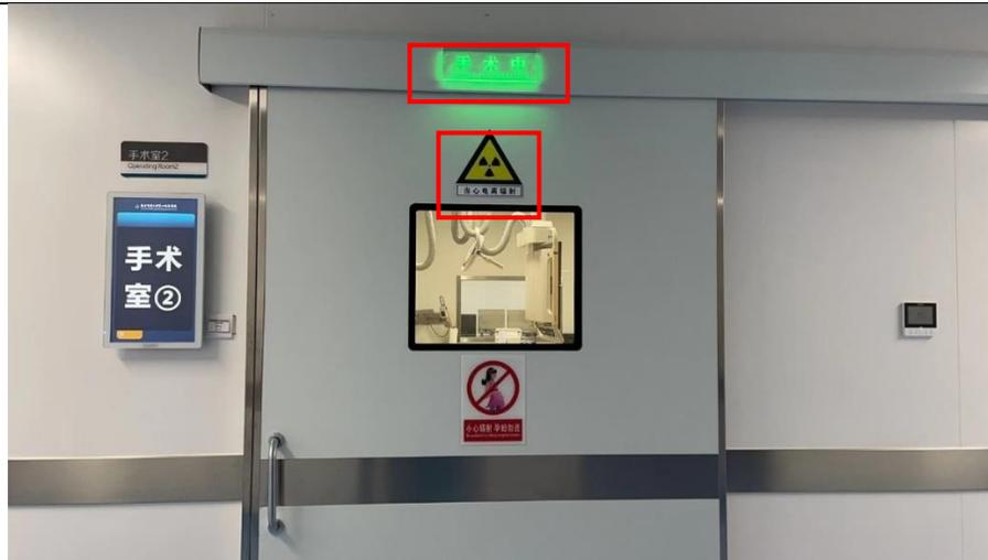
图3-4 门诊楼三层手术室1工作状态指示灯和电离辐射警告标志
