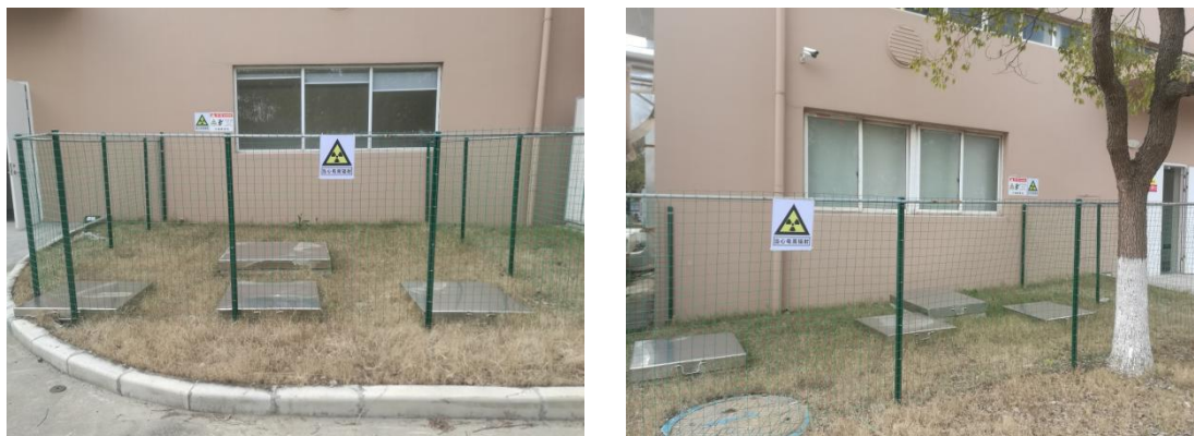
图 3-16 放射性废水衰变池
