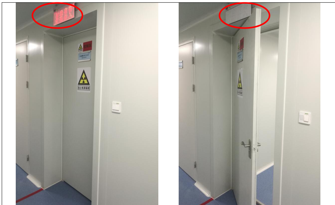
图3-6 工作状态指示灯和门灯联锁装置
