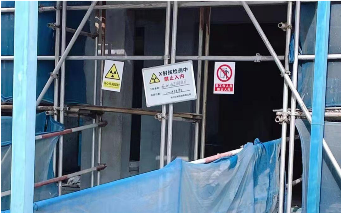
图 4-1 电离辐射警告标志及警示牌
